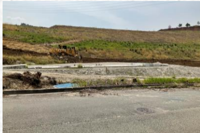
工事用道路製作
