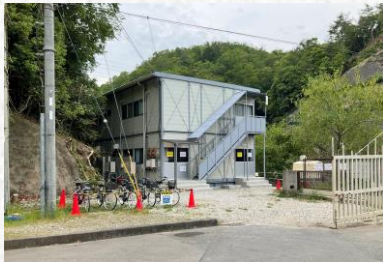
工事事務所完成
